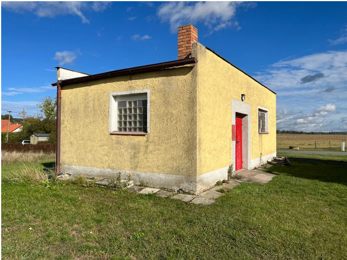
Hasičská zbrojnice čp. 59 – západní stěna – sklad materiálu a PHM, místo pro přístavbu skladu a garáže hasičské a komunální techniky
