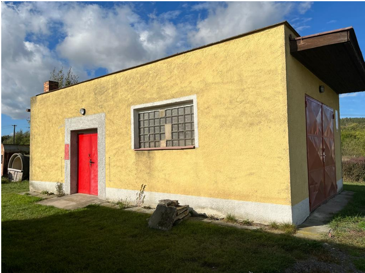
Hasičská zbrojnice čp. 59 – jižní boční stěna – garáž zásahové jednotky a vjezd do skladu materiálu a PHM
