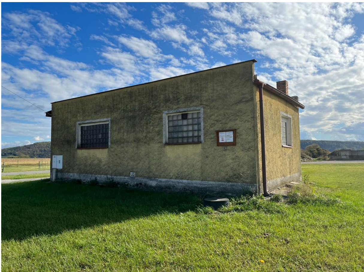
Hasičská zbrojnice čp. 59 – severní boční stěna – garáž a šatna zásahové jednotky
