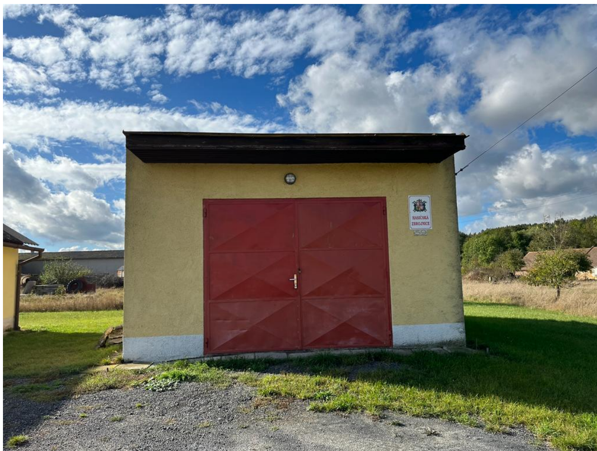
Hasičská zbrojnice čp. 59 – východní průčelí – vjezd do garáže zásahové techniky
