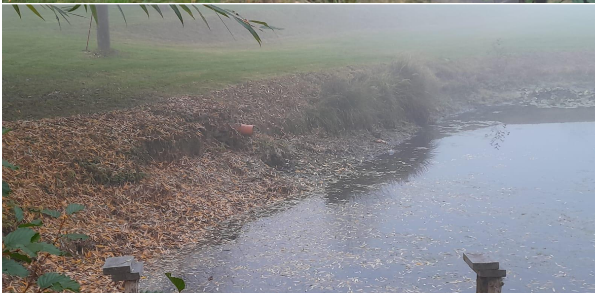
Degradované břehy navazující na hráz stavidla s pokleslou hladinou rybníka v říjnu 2024
