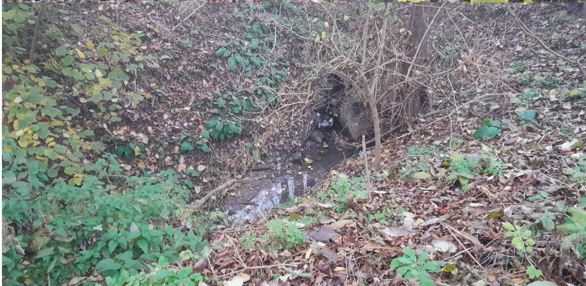
Místo se zbytky původní výtokové šachty z rybníka, společné s výtokem z obecní kanalizace
