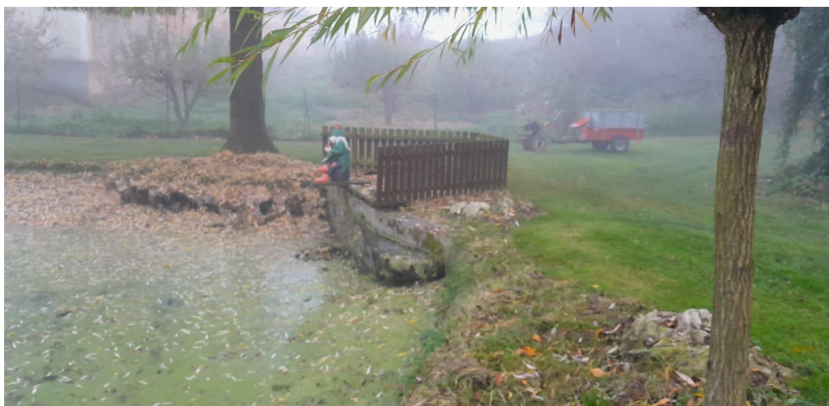
Obnažená hráz u stavidla s pokleslou hladinou rybníka v říjnu 2024
